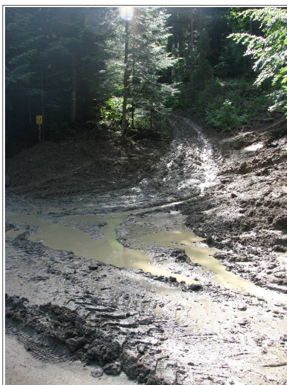
Fotografia nr 1. Skutki użytkowania dróg przy pracach leśnych w zlewni potoku Roztoki (w bliskim sąsiedztwie BdPN)
