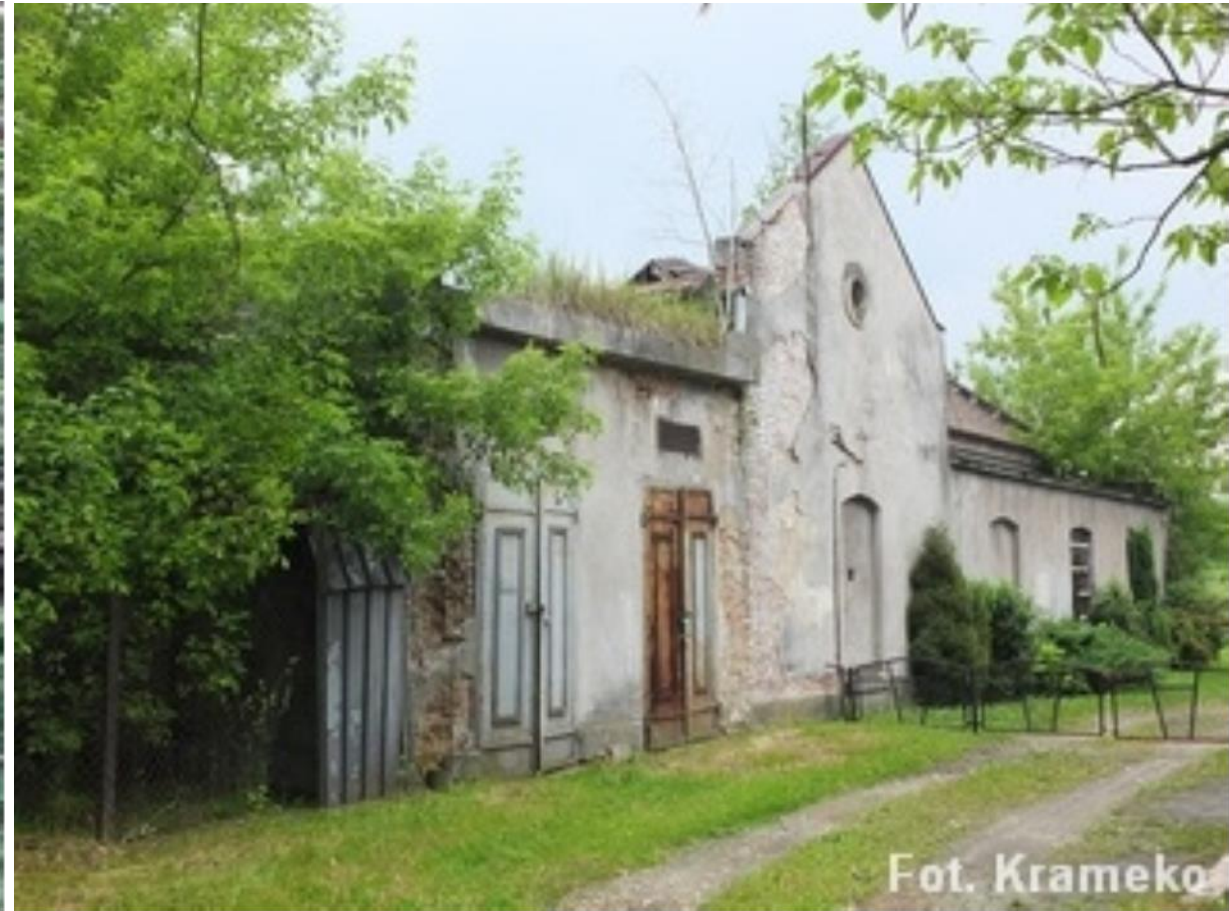
Fot. Krameko. Kraków, dom przy ul. Tynieckiej 48
