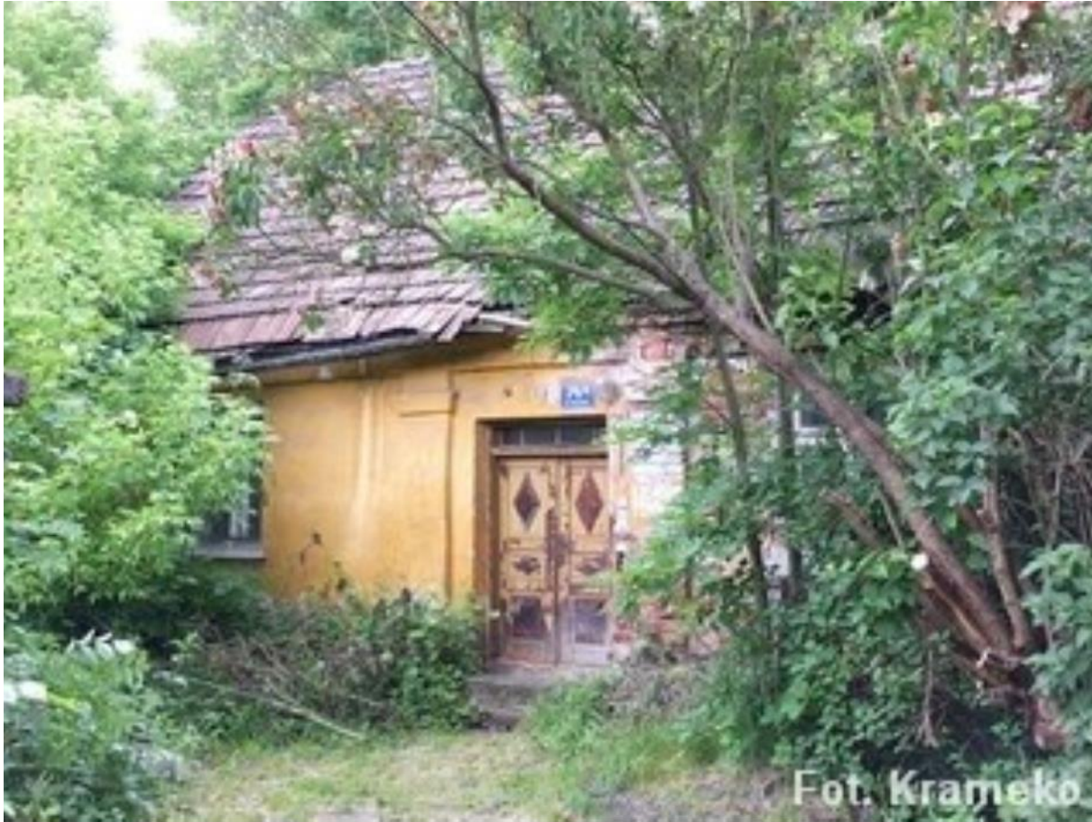
Fot. Krameko. Kraków, dom przy ul. Tynieckiej 74a
